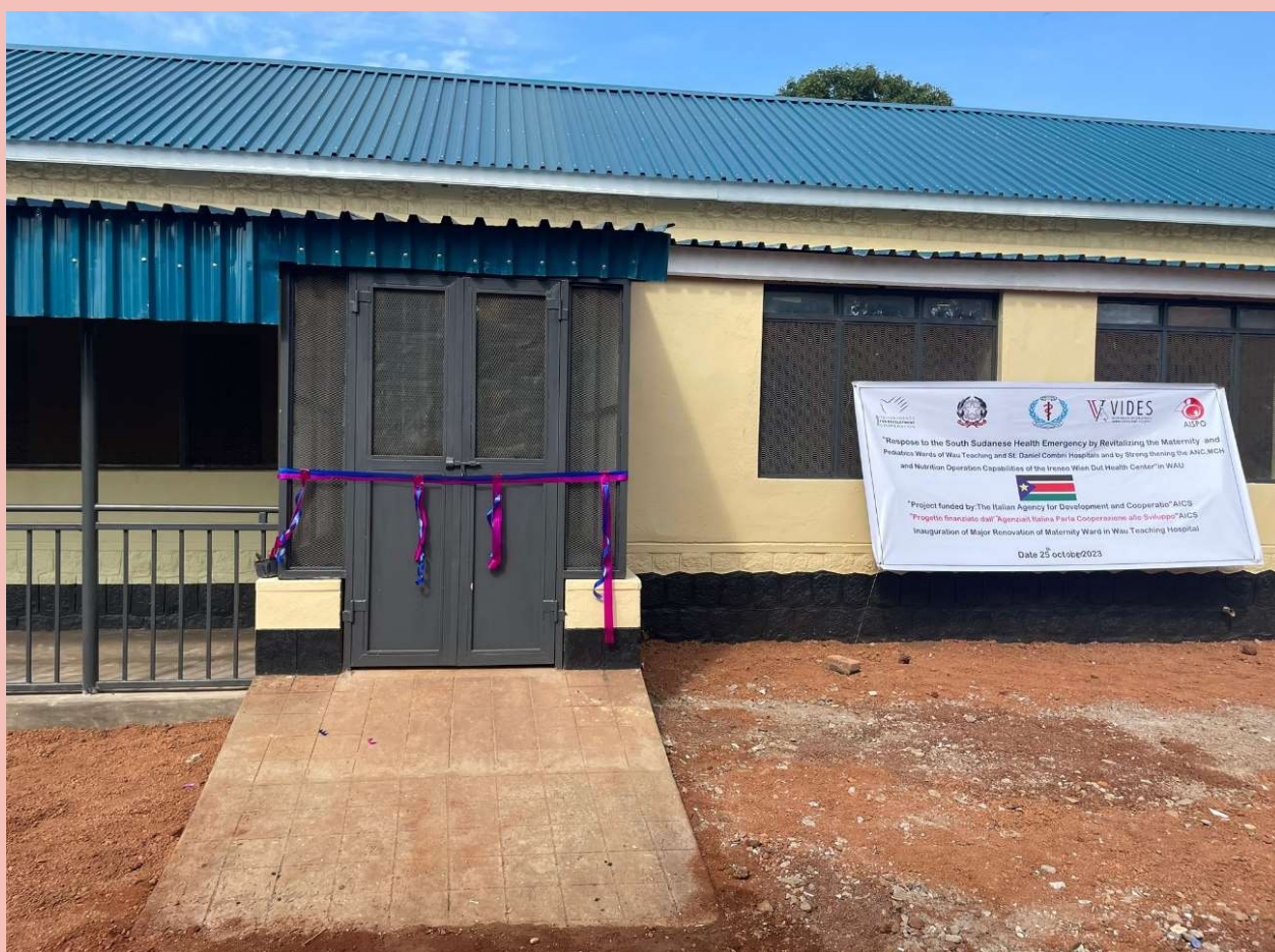
In foto il reparto di maternità del Wau Teaching Hospital riabilitato.
